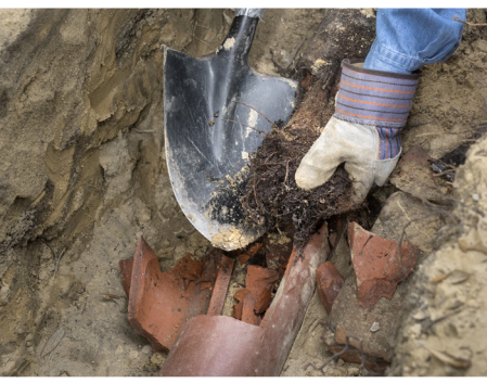
Thợ sửa ống nước tiến hành sửa chữa trên hệ thống nhánh tư nhân
